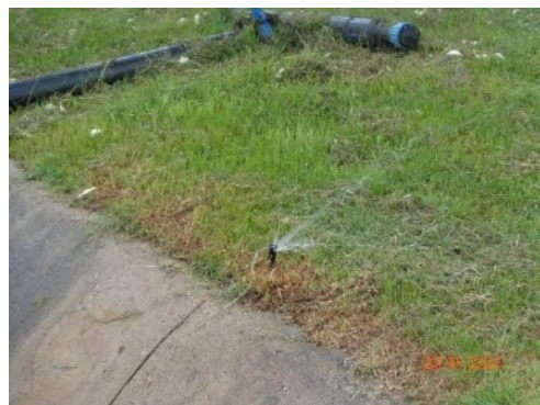
รูปที่ 2-27 การนำน้ำที่ผ่านการบำบัดแล้วไปใช้ประโยชน์ รดพื้นที่สีเขียวภายในพื้นที่โครงการ
