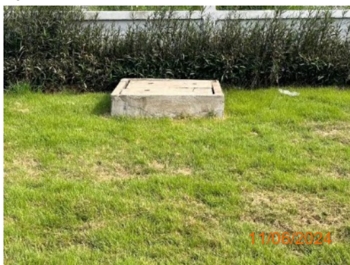
รูปที่ 2-21 Inspection Manhole
