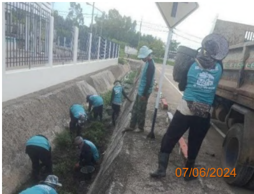
รูปที่ 2-32 การขุดลอกตะกอนในรางระบายน้ำฝน
