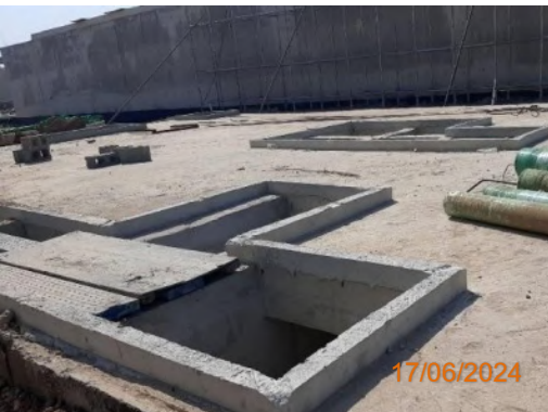
รูปที่ 2-5 บ่อพักน้ำทิ้งจากกิจกรรมก่อสร้าง
